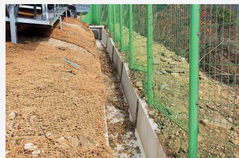
〈태양광 배수로 정비〉
