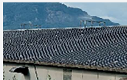
〈지붕 살수시설 작동여부 점검〉
