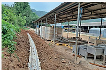
〈축사 배수로 정비〉
