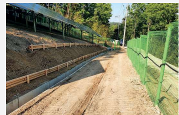
〈태양광 보완시공(통나무 없기)〉
