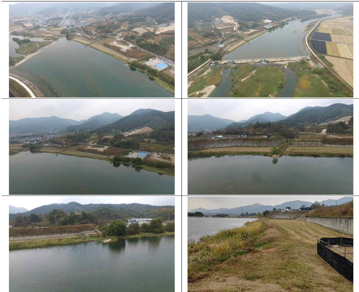
현장 전경(드론촬영 등)
